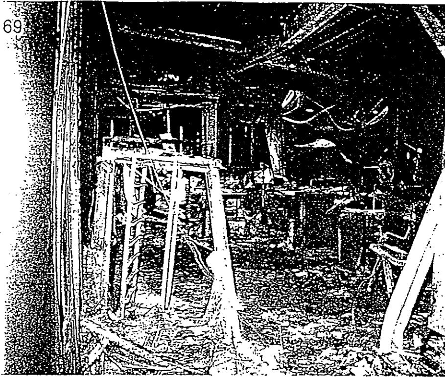
On observe la déformation plus importante des poutres et le fluage du poteau
