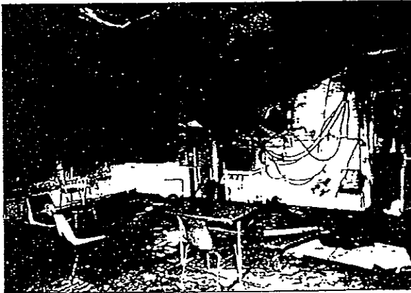
Photo n° 16 : le réfectoire près de la zone origine est peu détérioré.
